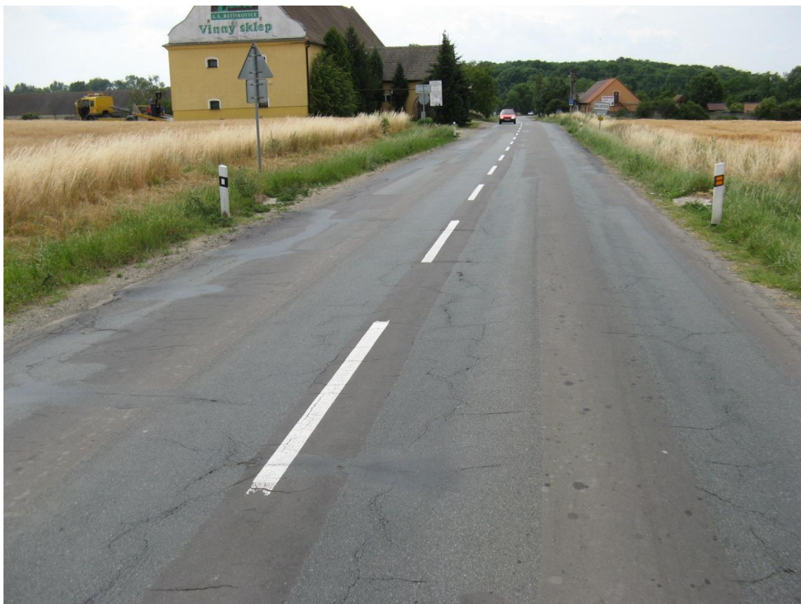
F61, km 55,920+ Vyjeté koleje, celoplošně mozaikové trhliny.
