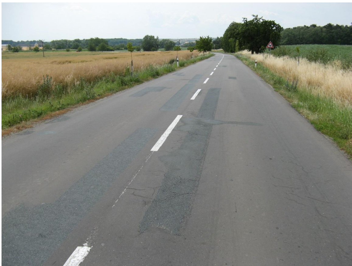
F43, km 54,610+ Povrch s drobnými trhlinkami ošetřovanými nátěrem.
