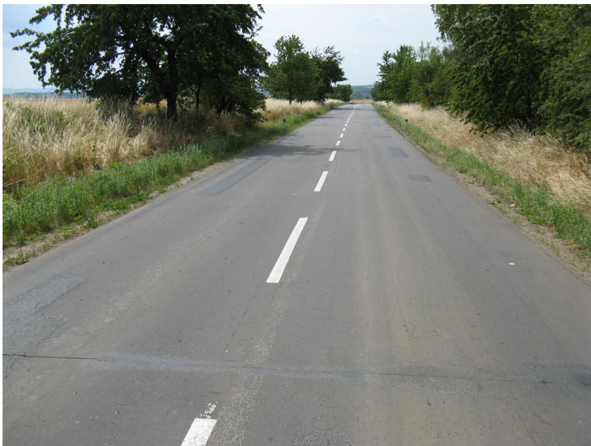
F35, km 53,810+ Příčné trhliny.
