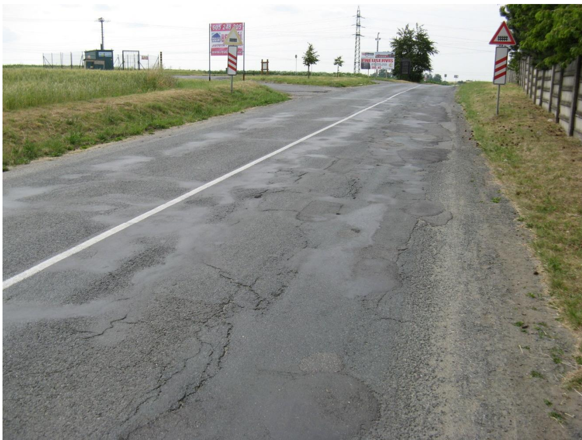
F13, km 51,860+ Vysprávký a nepravidelné hrboly, síťové trhliny, koroze.
