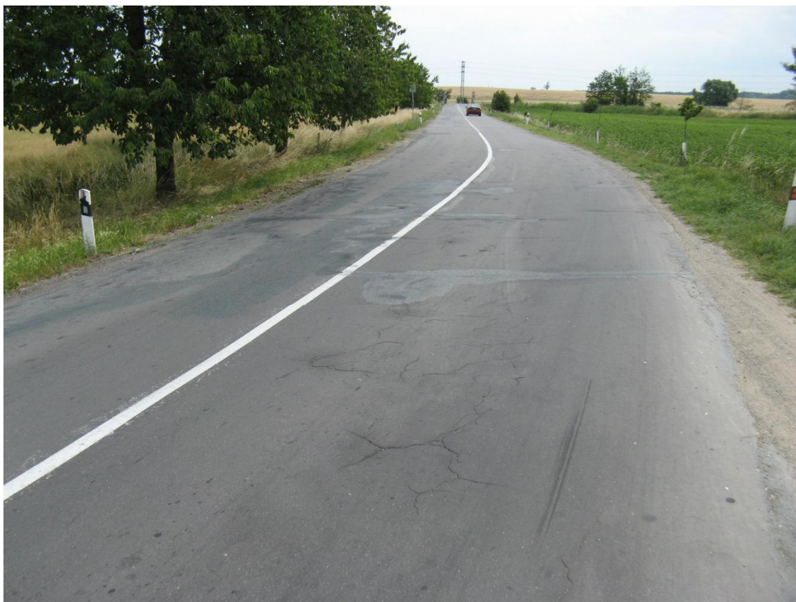
F48, km 55,010+ Mozaikové trhliny, příčné trhliny, vlevo vysprávký.
