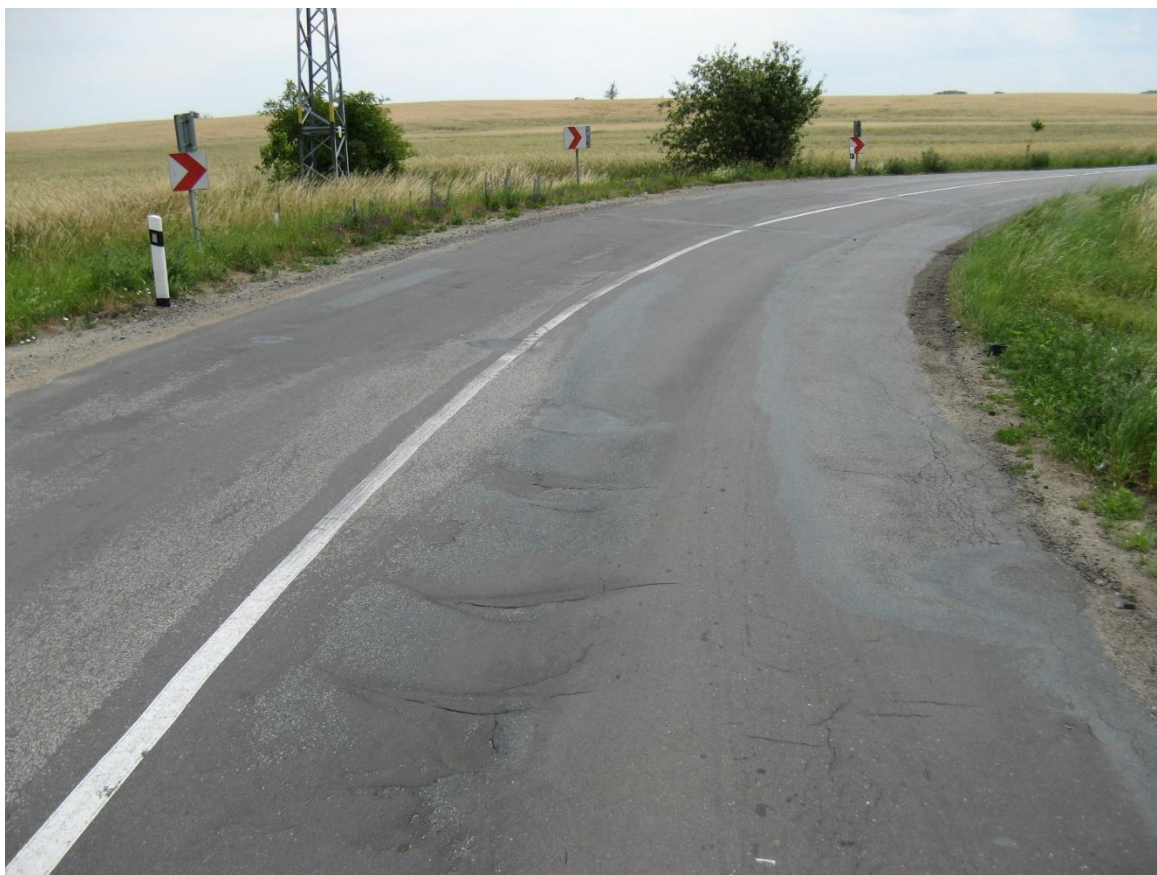
F50, km 55,220+ Výrazné plošné deformace a vysprávkvy.
