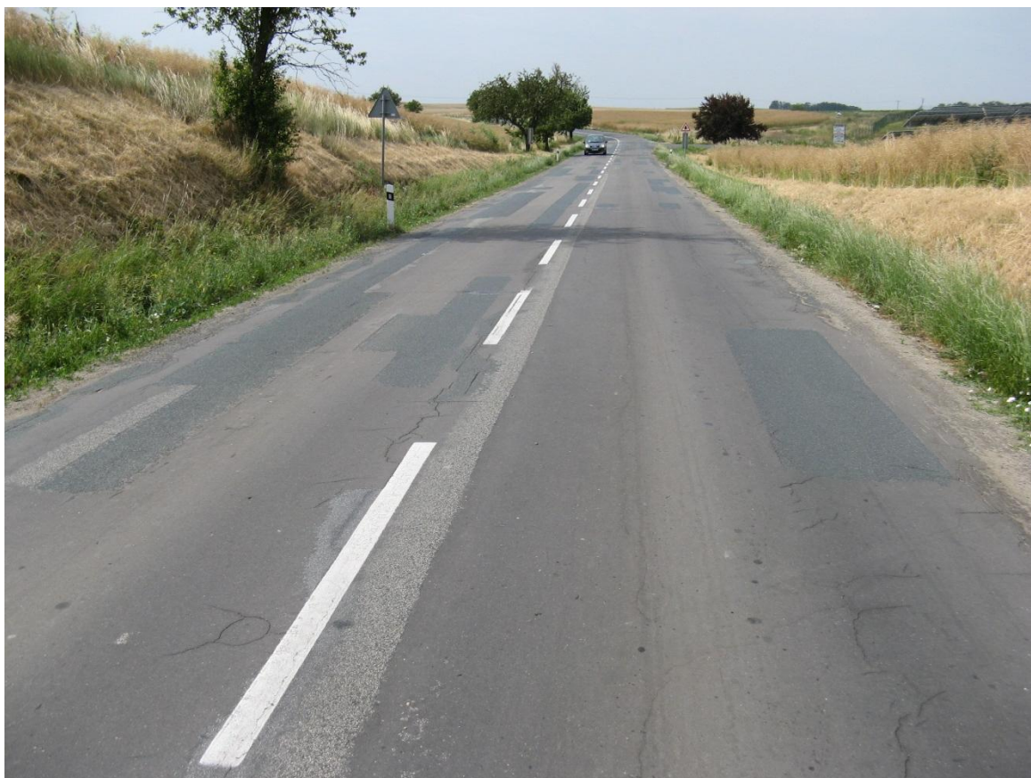
F18, km 52,220+ Vyjeté koleje, povrch s drobnými trhlinkami ošetřovanými nátěrem.
